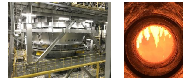
福島県双葉町 減容化施設
