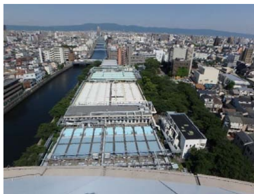
大阪 中浜下水処理場
