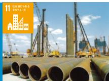
橋梁、港湾、河川、建築物などの基礎工事に使用される鋼管杭
