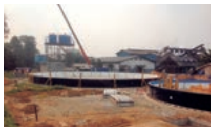
スマトラ島で建設中のパーム油廃液処理設備
