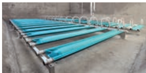
納入する下水処理関連製品（メンブレン式散気装置）
