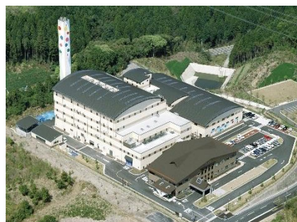
ごみ焼却・溶融プラント
