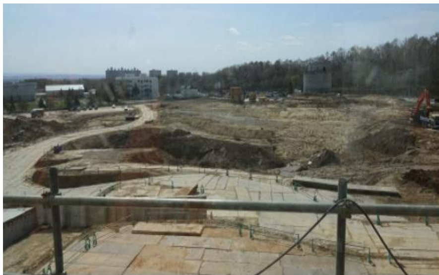
スタジアムから見た農業学習施設の建設用地
