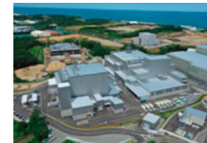
福島県双葉町減容化施設 (熔融技術を活用)
