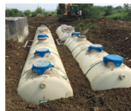
設置工事中の浄化槽
