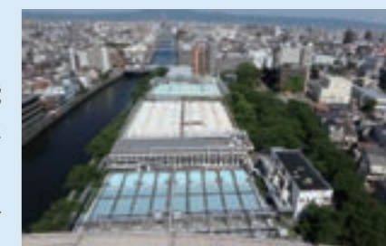
中浜下水処理場
