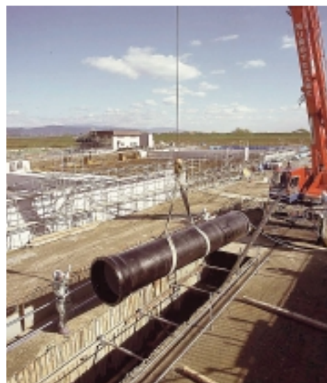
敷設中のダクタイル鑄鉄管
