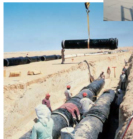
中東に敷設中のダクタイル鉄管
