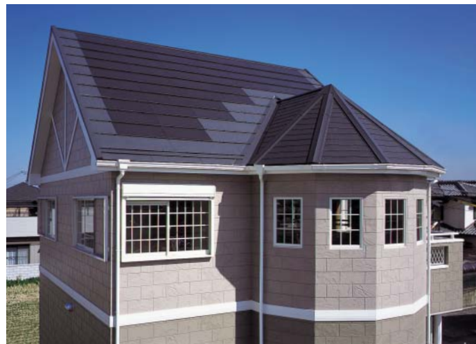
エコロニー施工事例
