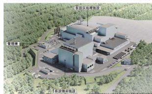
双葉町減容化施設（溶融技術を活用）
