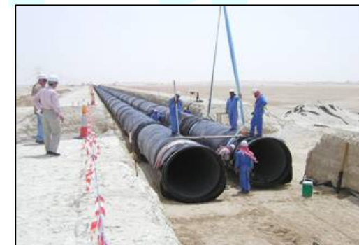
ダクタイル鉄管（敷設）
