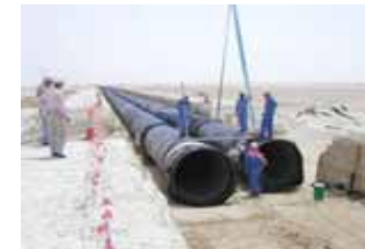
ダクタイル鉄管(敷設)
