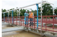
ミャンマーで 上下水処理施設を建設
