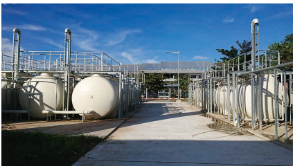
●浄化槽 下水道が整備されていない地域の 排水処理を行います。
