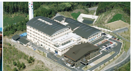
●ごみ焼却プラント 灰・熔融プラント 家庭からの燃えるごみを焼却処理して減容化を図る だけでなく、高温の廃熱を利用して発電を行い、低炭 素化社会にも貢献する施設です。
