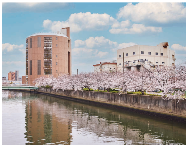
大阪市中浜下水処理場
