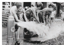
カンボジアで日本初の海外水道工事を竣工
