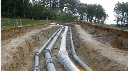
●ダクタイル鉄管 上下水道や農業用水などのインフラに使用されます。
