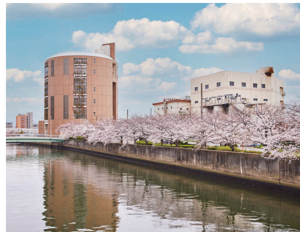
大阪市中浜下水処理場
