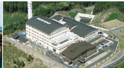
●ごみ焼却プラント 灰・溶融プラント 家庭からの燃えるごみを焼却処理して減容化を図るだけでなく、高温の廃熱を利用して発電を行い、低炭素化社会にも貢献する施設です。
