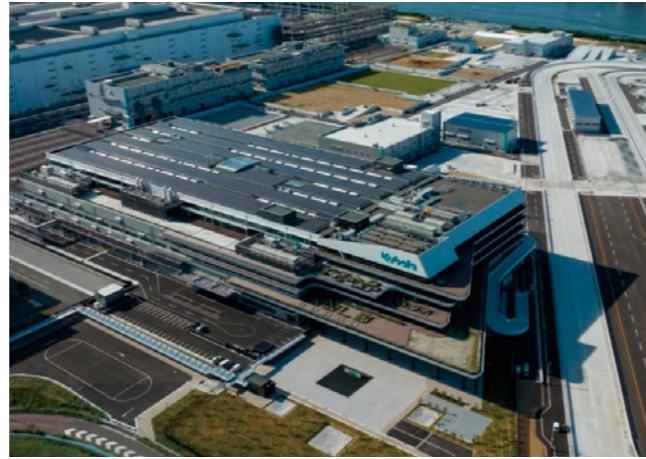
2022年9月に開設したクボタグローバル技術研究所では、出力1,566kWの太陽光パネルを設置しました。
