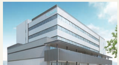
日本 枚方製造所内の総合棟(※建設中)
