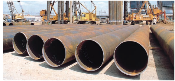
鋼管 橋梁、港湾、河川、建築物などの基礎工事に使用されます。
