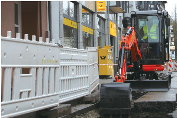
ミニバックホー 土木作業などを行います。市街地など狭い現場を得意とします。
