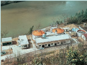
事業部発足後に初受注した 広島県三次市のし尿処理施設
