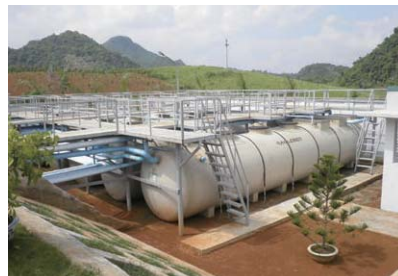
浄化槽 下水道が整備されていない地域の排水処理を行います。
