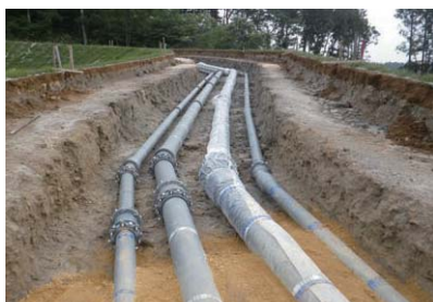
ダクタイル鉄管 上下水道や農業用水などのインフラに使用されます。
