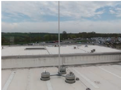
多発する雷雨への対策として導入している 雷保護システム
