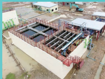
ティラワ工業団地Zone Aに施工した浄水場
