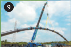
9 鉄管 水道・下水道・ガス管などのインフラとして使用されます。
