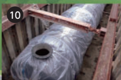
10 耐震貯水槽 地震などの災害による断水に備えて飲料水を確保します。
