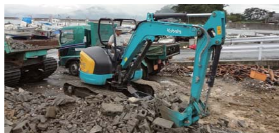
瓦礫撤去作業でクボタの建設機械が活躍
