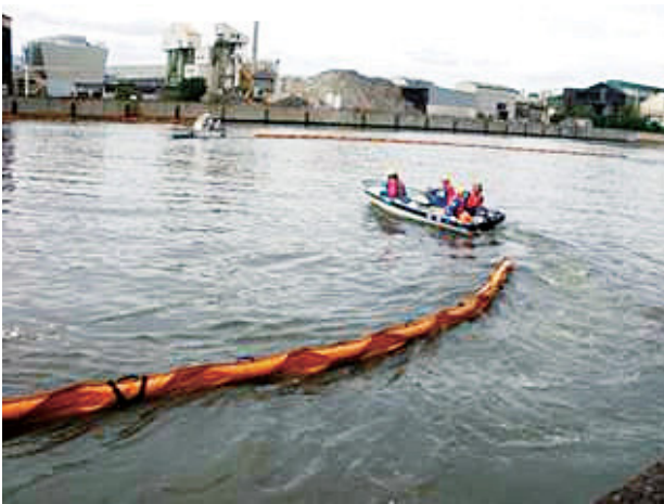
オイルフェンスの設置により、油の拡散を防止
