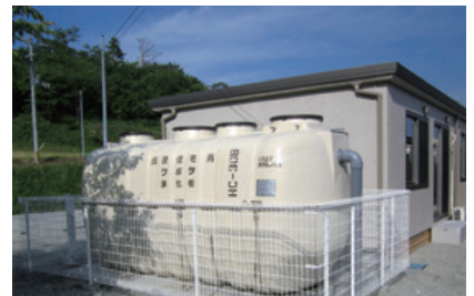
仮設住宅等の排水処理に役立つ 浄化槽
