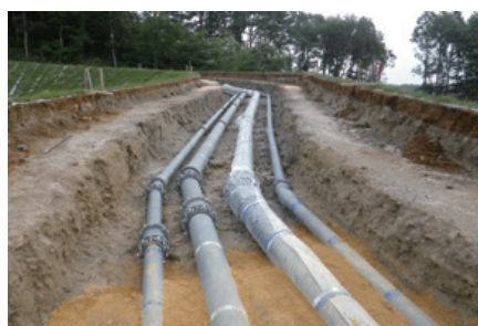
ダクタイル鉄管 上下水道や農業用水などのインフラに使用されます。
