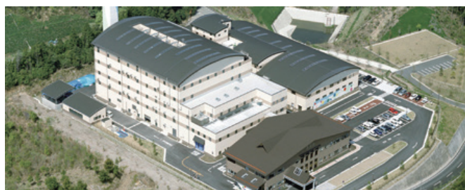
ごみ焼却プラント／灰・溶融プラント 家庭からの燃えるごみを焼却処理して減容化を図るだけでなく、高温の廃熱を利用して発電を行い低炭素化社会にも貢献する施設です。
