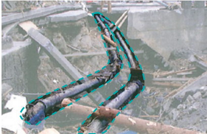
海外の断層地帯でも採用された 大口径耐震型ダクタイル鉄管 (アメリカ)
