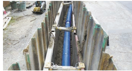
プラスチックパイプ 水道・下水道・ガス管などのインフラとして使用されます。
