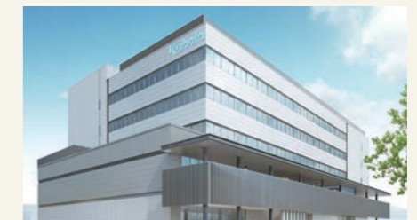
日本 枚方製造所内の総合棟(※建設中)
