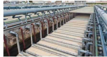
液中膜ユニット 生活排水や産業排水など下水を浄化します。
