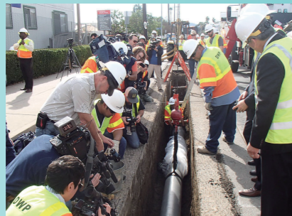
ロサンゼルスでの耐震管「GENEX®」の施工現場
