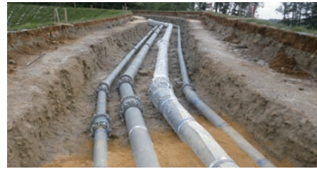
ダクタイル鉄管 上下水道や農業用水などのインフラに使用されます。
