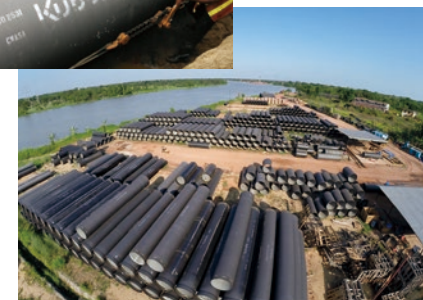
ダクタイル鉄管(φ900~1,200mm)ストックヤード
