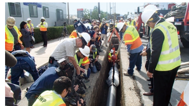
耐震管「GENEX®」の施工現場 (米国ロサンゼルス)
