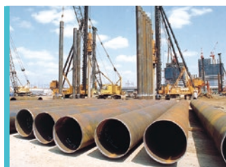
鋼管 橋梁、港湾、河川、建築物などの 基礎工事に使用されます。
