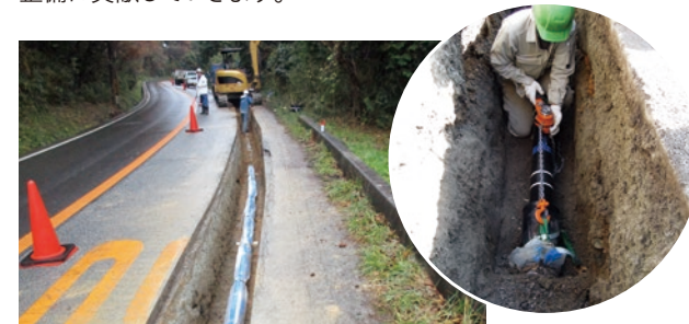
耐震管「NECS®」の施工現場 (大阪府能勢町)
