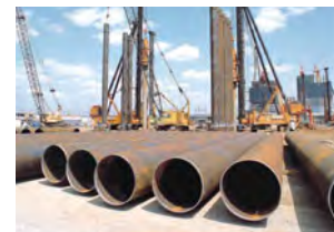
22 鋼管 橋梁、港湾、河川、建築物などの基礎工事に使用されます。
