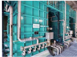
14 セラミック膜 河川や水源地の水を高度浄化処理し、飲料水をつくります。
