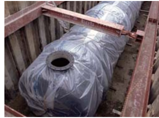
10 耐震貯水槽 地震などの災害による断水に備えて飲料水を確保します。
