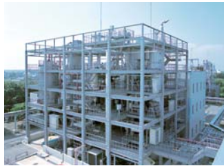
17 下水汚泥焼却炉 下水処理の際に発生する汚泥を焼却・溶融するプラントです。
