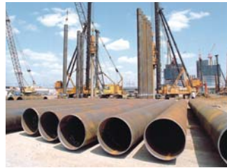
18 鋼管 橋梁、港湾、河川、建築物などの基礎工事に使用されます。
