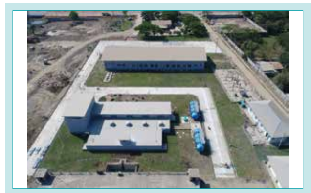
図10 完成したラガンビンポンプ場 Fig. 10 Lagunbyin Pumping Station
