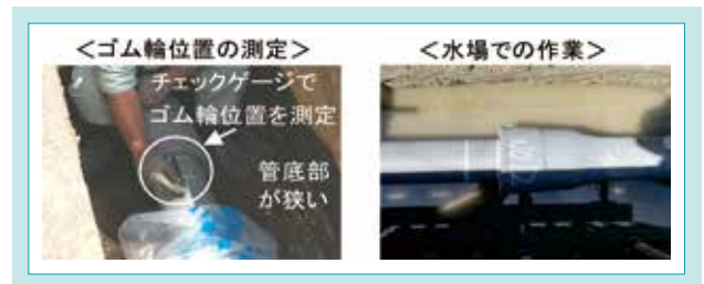
図6 ゴム輪の位置確認 Fig. 6 Checking Positions of a Rubber Gasket
