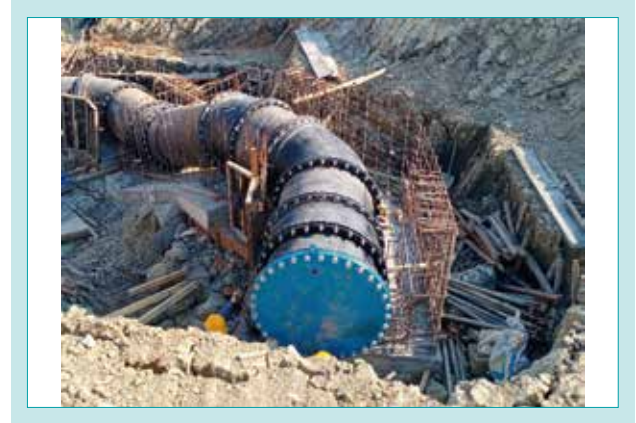
図9 ダクタイル鉄管(口径 1600 mm)の施工状況 Fig. 9 Ductile Iron Pipe Installation (DN 1600 mm)
