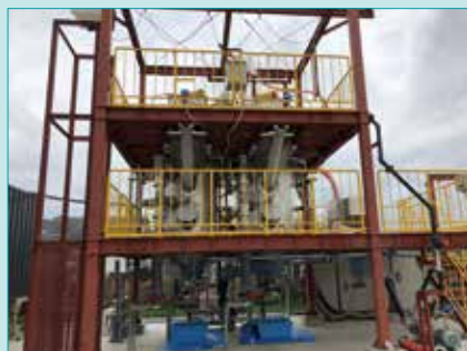
図3-2 メタン発酵処理設備 Fig. 3-2 Fermentation
