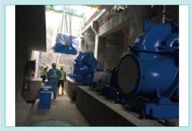
図8 ポンプの据付状況 Fig. 8 Pump Installation
