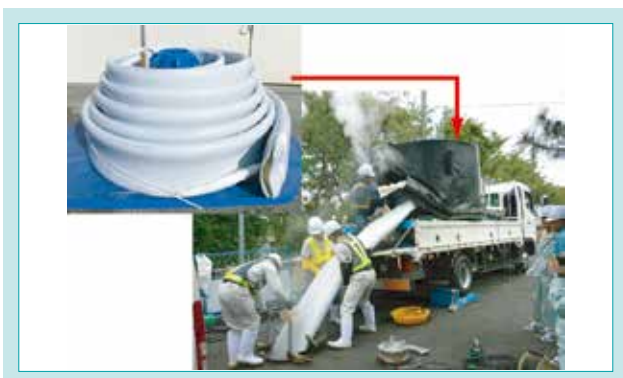
図3 長尺パイプの外観と施工状況
