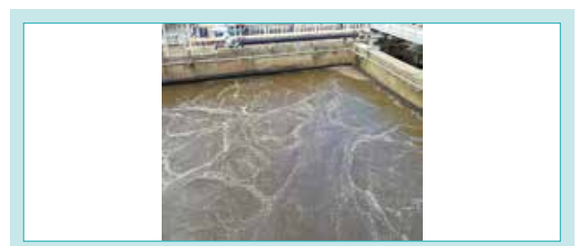
図 5 現地での曝気状態 (2018年8月)
