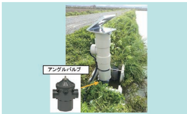
図6 給水側設置事例 (アングルバルブ) Fig. 6 Water Supply Side Installation Example (Angle Valve)
