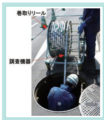
図 16 実管路での調査状況
