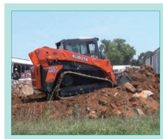
図8 傾斜地での作業 Fig. 8 Working on a Slope
