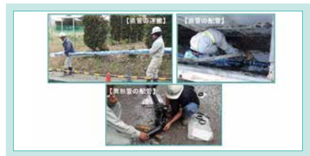
図 21 管の運搬・配管状況
