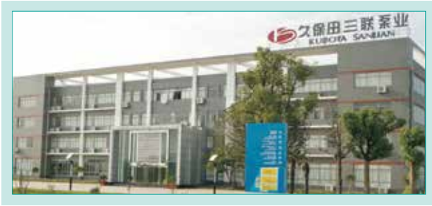
図1 久保田三聯ポンプ工場 Fig. 1 Kubota Sanlian Pump Factory
