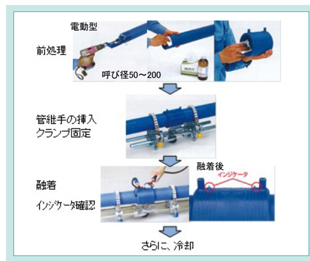
図2 PE管のEF接合
