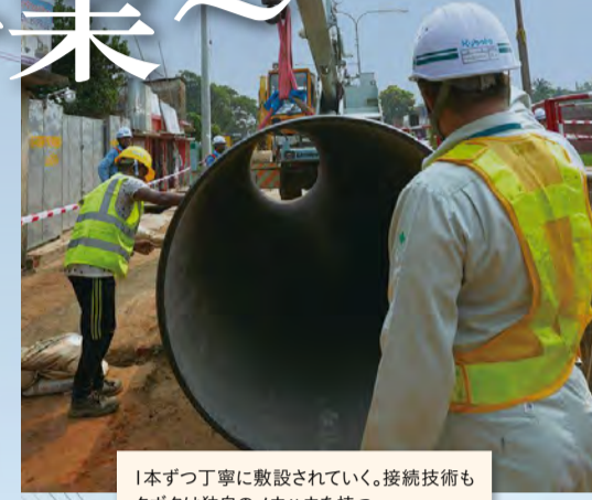
1本ずつ丁寧に敷設されていく。接続技術もクボタ独自のノウハウを持つ
